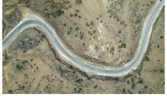
Yavuzeli Yakuplu Mahallesi Sathi Kaplama Yapım Çalışması
