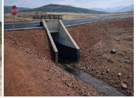
İbrahim Şehir Mahallesi Menfez yapımı
