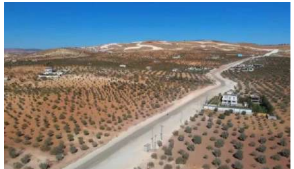
Nizip Fıstıkkent Bölgesi İmar Yolları Açma Çalışması
