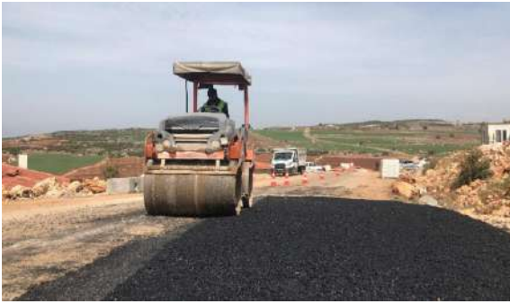
Nurdağı Asfalt Yama Çalışması
