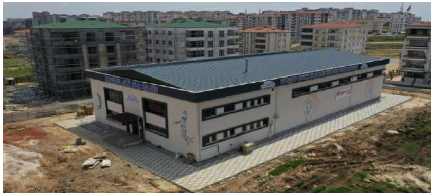
Ertuğrul Gazi Yüzme Havuzu Çatı GES Uygulaması
