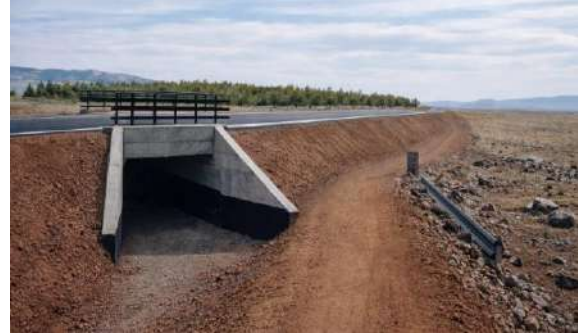
Nurdağı Emirler Köyü Menfez yapımı
