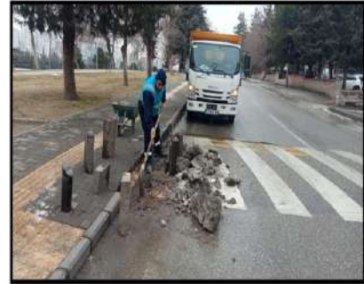
Gazikent Mahallesi kaldırım onarım çalışması
