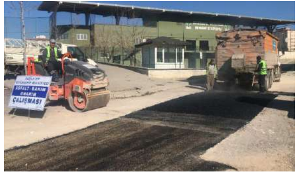
Beykent Mahallesi Asfalt Yama Çalışması
