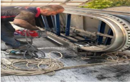
"Yürüyen Merdiven Bakım Onarım İşi"
