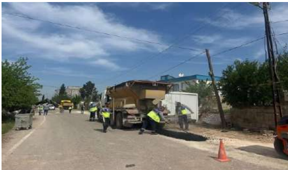
Araban Yolveren Mahallesi Asfalt Yama Çalışması
