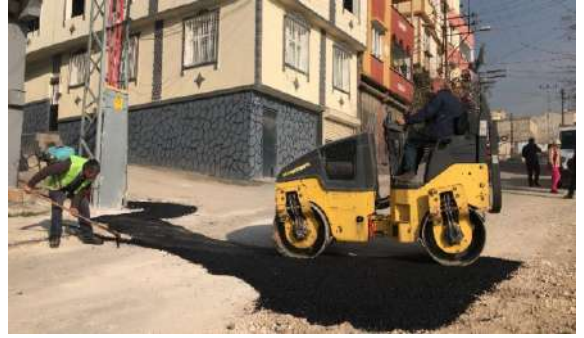
Kahvelipınar Mahallesi Asfalt Yama Çalışması
