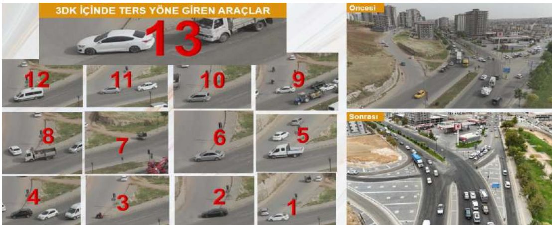
Düzensiz parklanmanın önüne geçilmiştir. Orta refüj yapılmıştır park cepleri tanımlı hale getirilmiştir.
